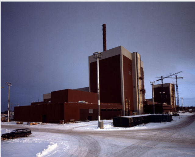
OL1 ja OL2 rakennusvaiheessa 1978.
