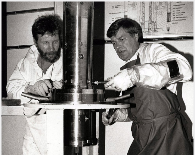
Ilkka Flinkman ja Risto Levonen kokoamassa säätösauvaa 1989.
